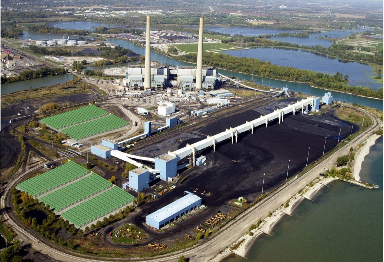
Vue aérienne de la centrale de cogénération (Cogen) du Massachusetts Institute of Technology (MIT) couplée aux bioréacteurs à microalgues de GreenFuel Corporation (en vert sur la photo)
